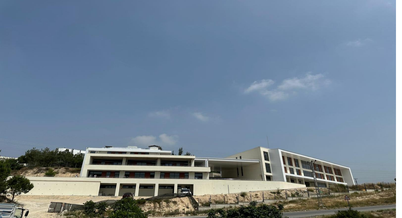
Tarsus Üniversitesi Yabancı Diller Hazırlık Sınıfları Derslik Binası İkmal İnşaatı
