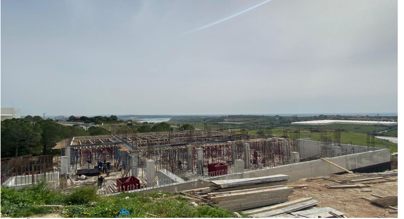
Tarsus Üniversitesi Kütüphane Binası İnşaatı
