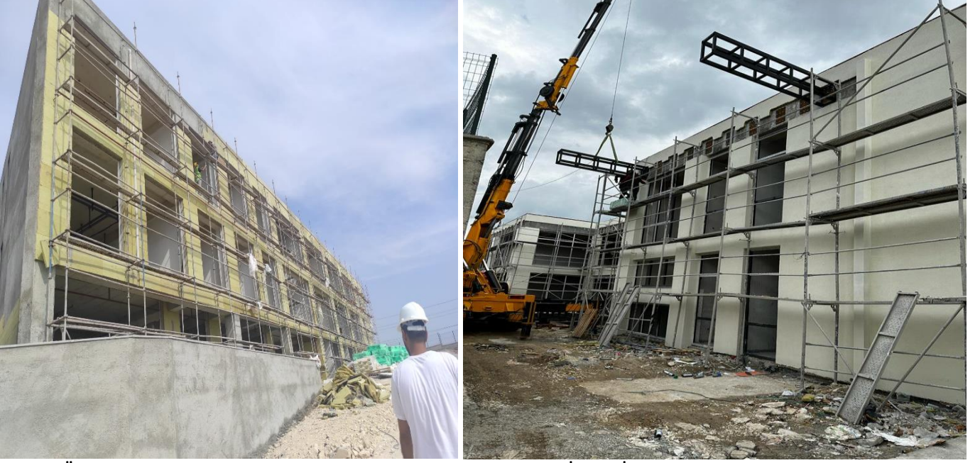
Tarsus Üniversitesi Yabancı Diller Hazırlık Sınıfları Derslik Binası İkmal İnşaatı
