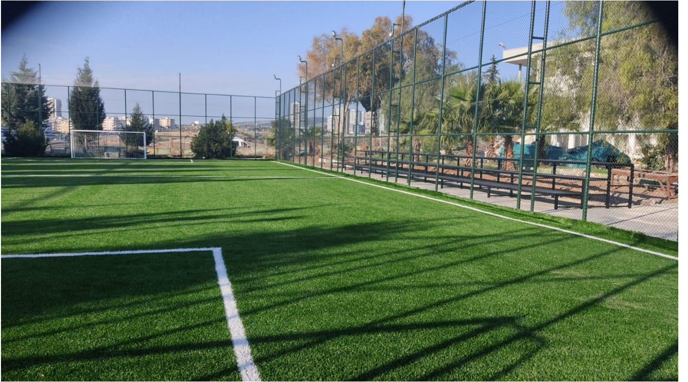
Tarsus Üniversitesi MYO Kampüsü Spor Tesisleri Yapım İşi
