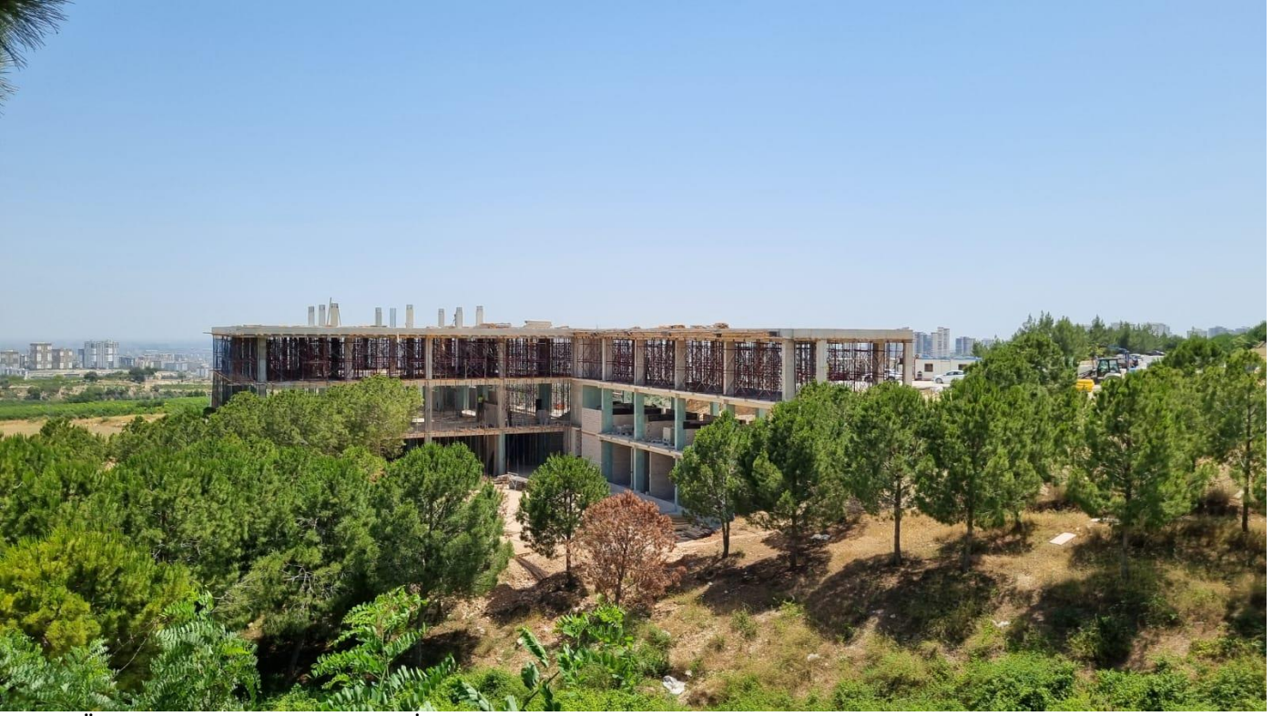
Tarsus Üniversitesi Kütüphane Binası İnşaatı
