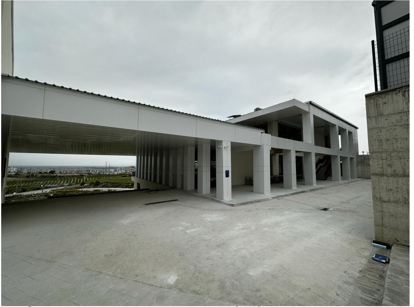
Tarsus Üniversitesi Yabancı Diller Hazırlık Sınıfları Derslik Binası İkmal İnşaatı
