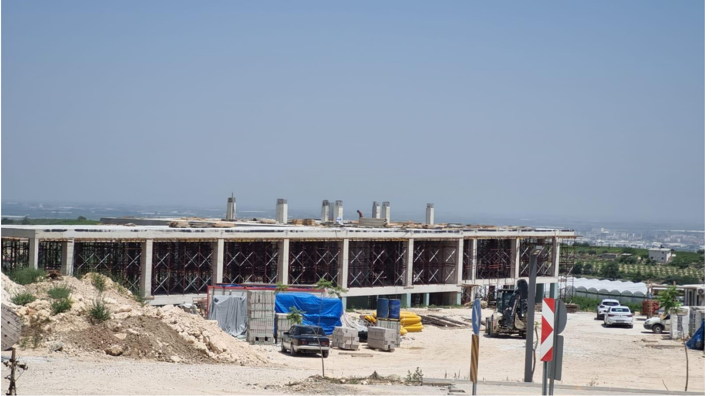
Tarsus Üniversitesi Kütüphane Binası İnşaatı
