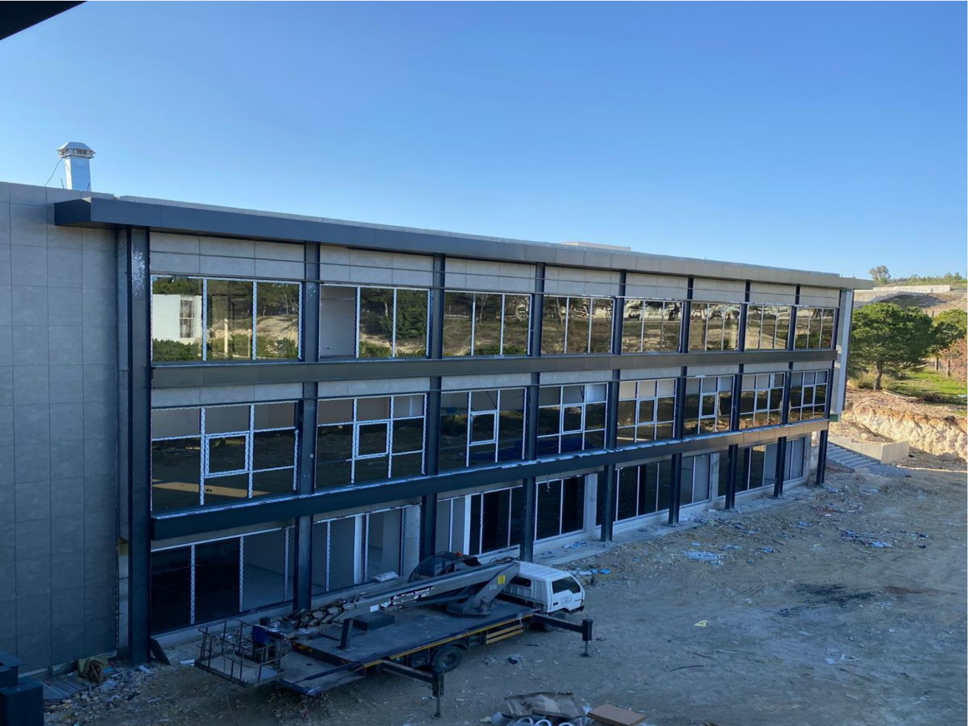
Tarsus Üniversitesi Kütüphane Binası İnşaatı
